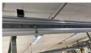
detalhe da instalação
